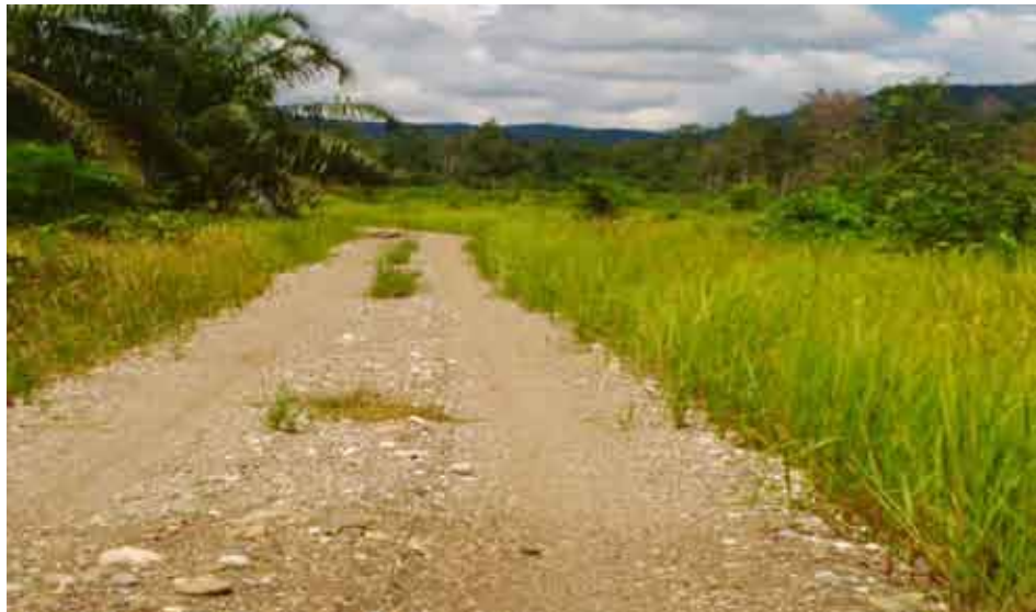
Gambar. 7 Jalan produksi yang dibangun melalui proyek PNPM
